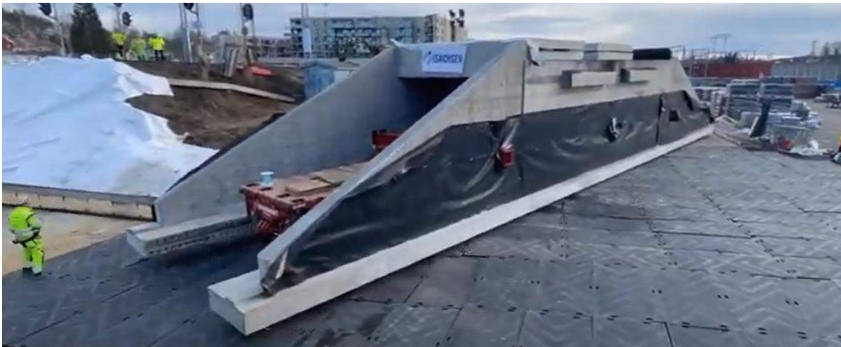
Figur 14 - Innkjøring av kulvert
