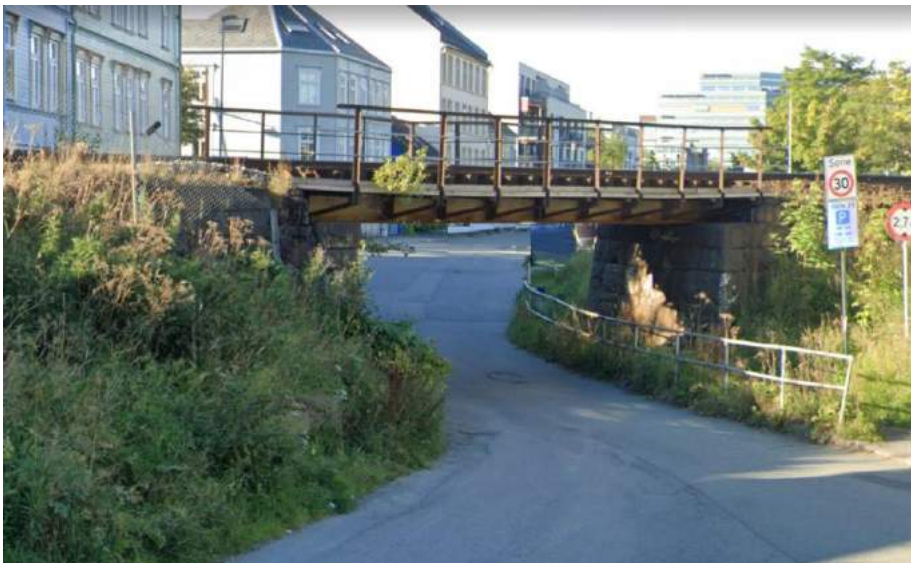
Figur 1: Eksisterende jernbanebro over Strandveien.
