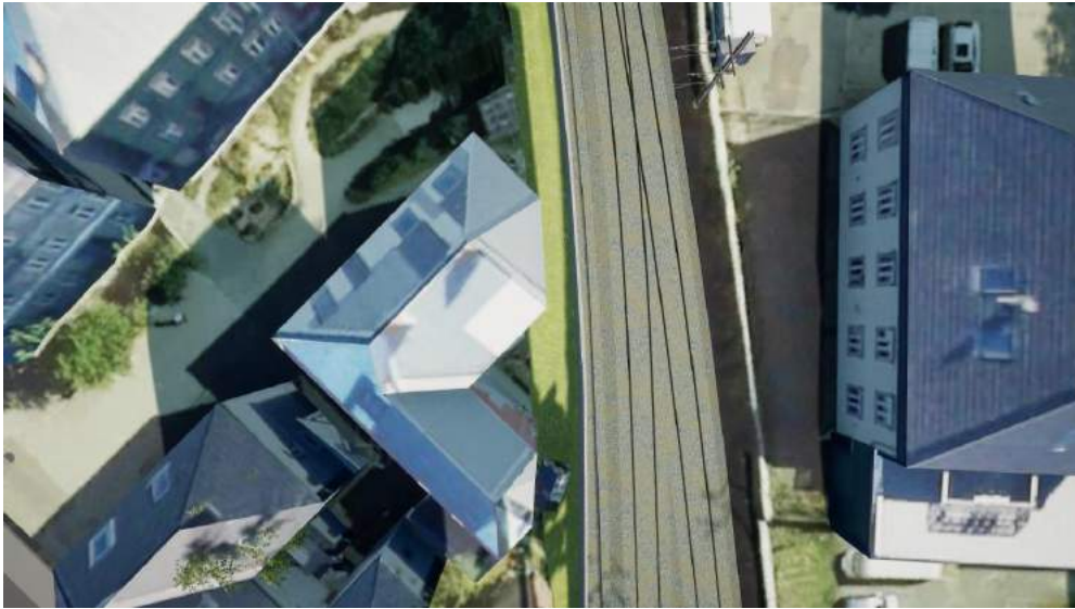
Figur 16: Jernbanespor med tilhørende infrastruktur kommer nærmere Gregus gate 10.
