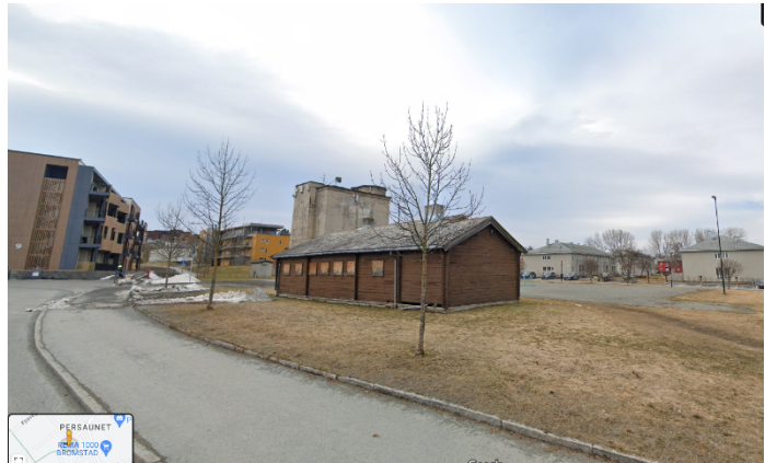
Figur 6: Badstubygget i forgrunnen og Forsvarets bunker i bakgrunnen. (Google streetview).
