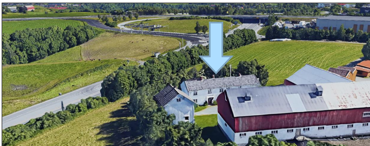
Figur 5 Vestre Rosten 120 (markert) i avstand fra E6, men med utsyn til en stor del av vegen som gjør skjerming langs veg utfordrende. Bilde hentet fra Google maps.
