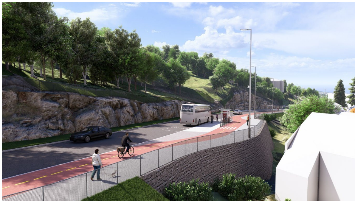
Figur 17: Bussholdeplass Clara Holst veg mot byen med støttemur og rekkverk bak holdeplassen.
