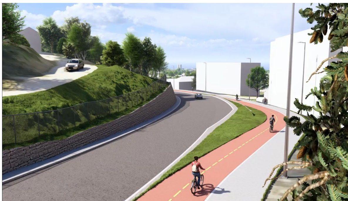
Figur 26: Mur for å redusere inngrep i grøntområde ved Luftkrigsskolen. Areal for renovasjon ved Clara Holst veg 23 på høyre side av vegen.
