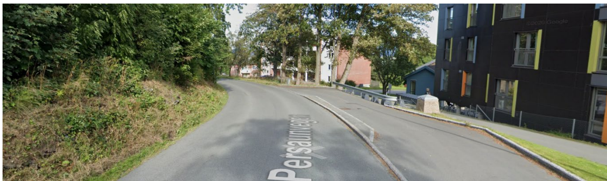
Figur 21: Renovasjonsanlegg ved Clara Holst veg 23 på høyre side av veien. (Google maps)
