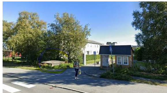
Figur 8 Inngangen til Persaunet Leir. (Kilde: Google)
