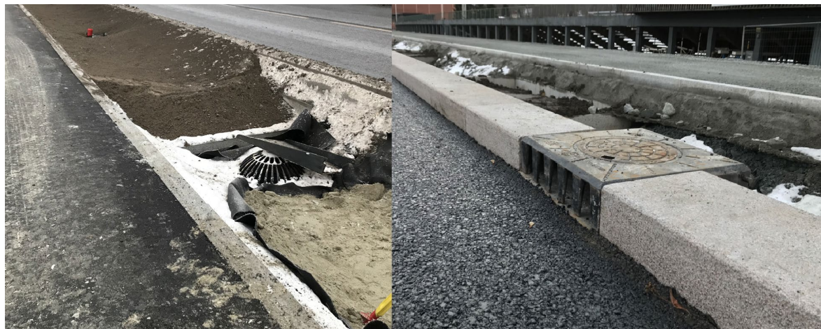
Figur 4.2 Infrastruktur knyttet til regnbed under montering i Bjørnstjerne Bjørnsons gate, SVV rapport nr 393
