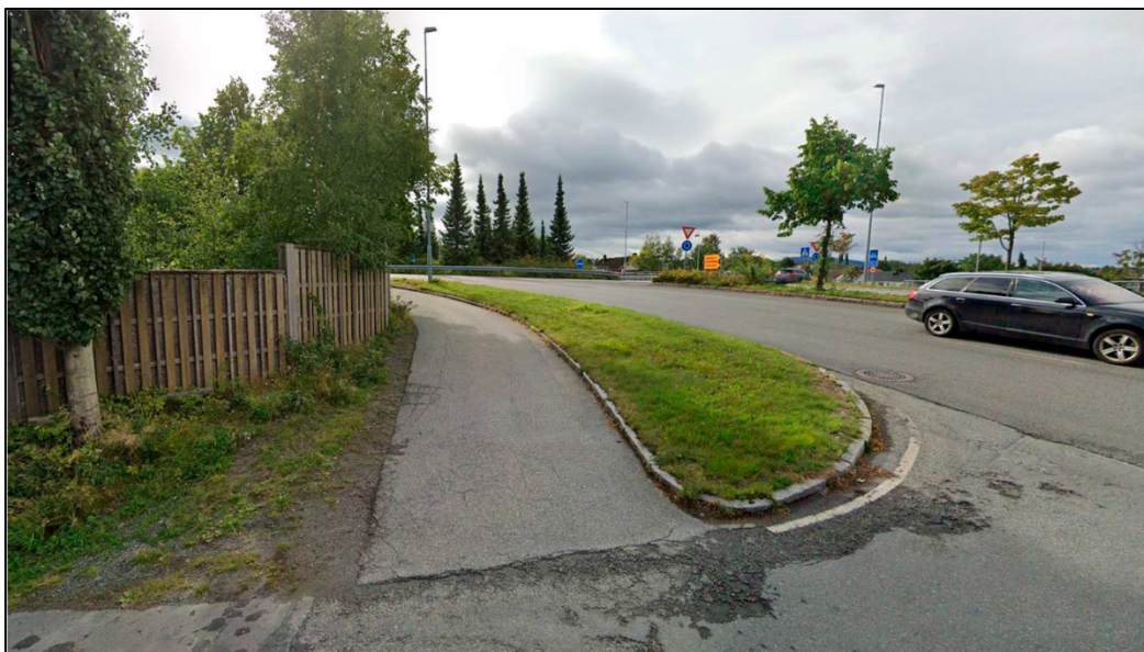
Figur 11 Dårlig siktforhold fra Røllikvegen mot Nardokrysset i sør. Kilde: Google Street View, august 2020
