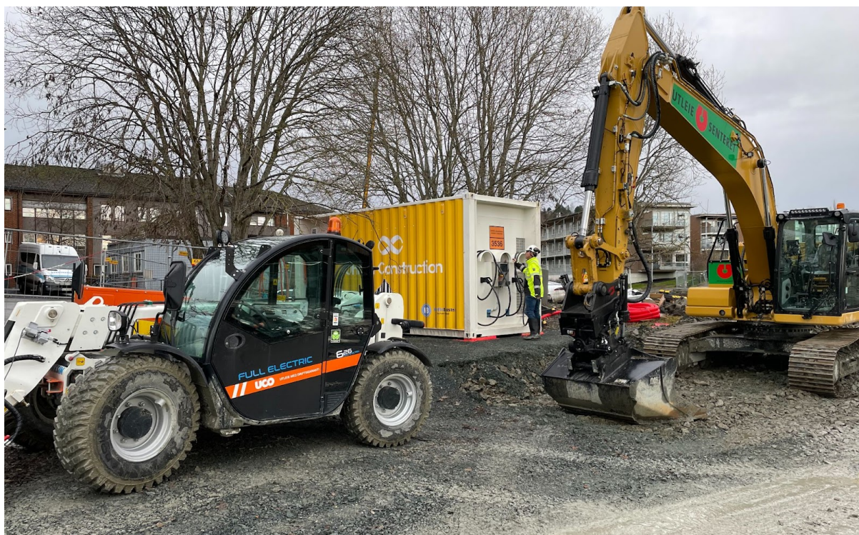
Lading av elektriske anleggsmaskiner via mobilt batteri Foto: Knut Okkenhaug
