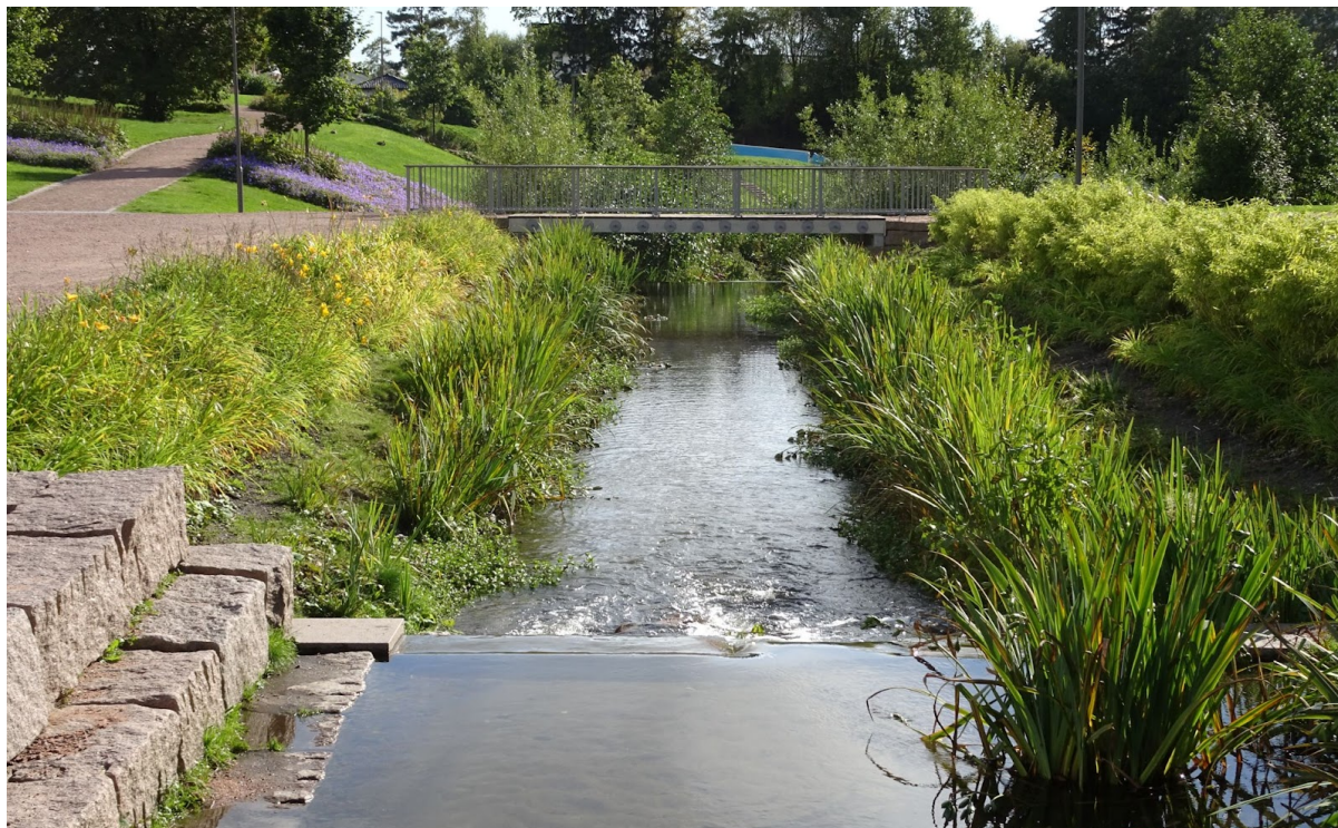
Eksempel på naturbasert overvannsløsning i Bjerkedalen park i Oslo. Foto: Byplankontoret.
