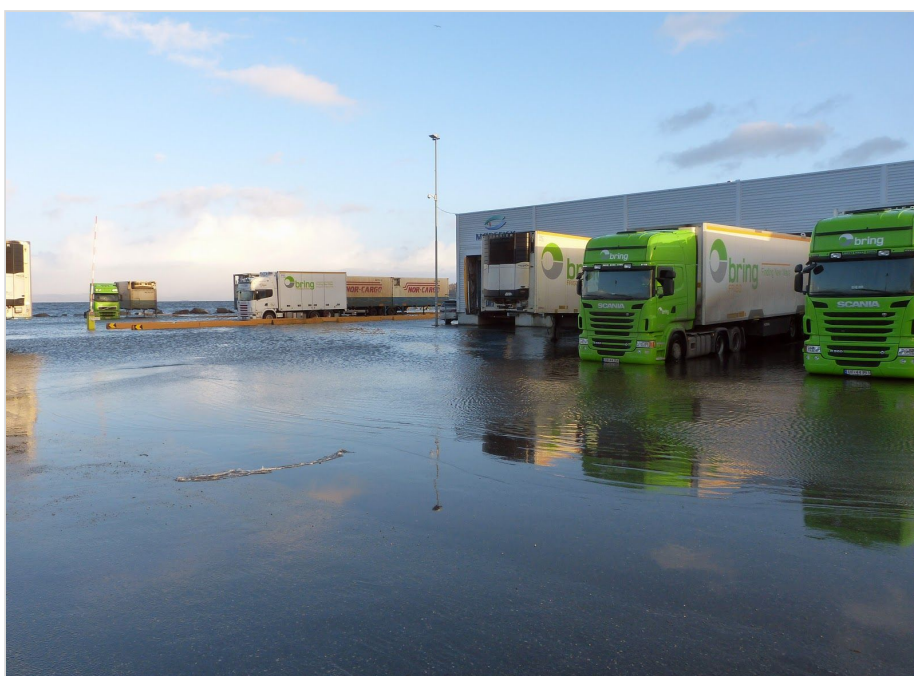
Som følge av klimaendringene vil det å bygge i vannkanten by på utfordringer. Bildet er fra Brattøra i 2011. Foto: Carl Erik Eriksson.
