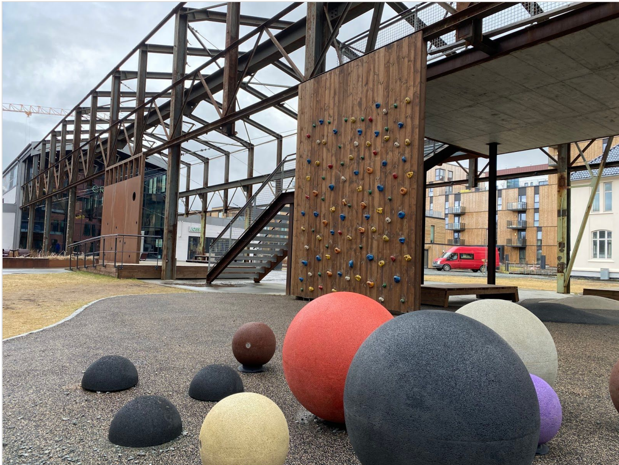
Gamle Bergs maskinhall på Lilleby er et eksempel på identitetsbevarende gjenbruk som grunnlag for opplevelsesverdier i byutviklingen. Foto: Tove Hellem
