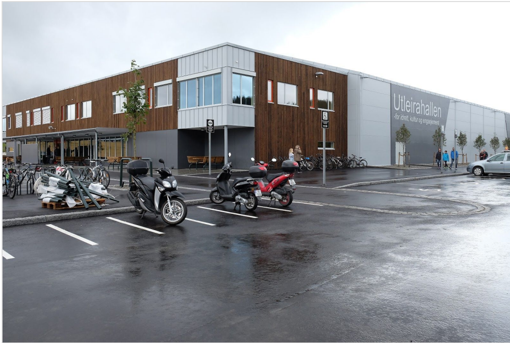
Utleira idrettsanlegg og hall. Ferdigstilt i 2015. Foto Carl-Erik Eriksson.
