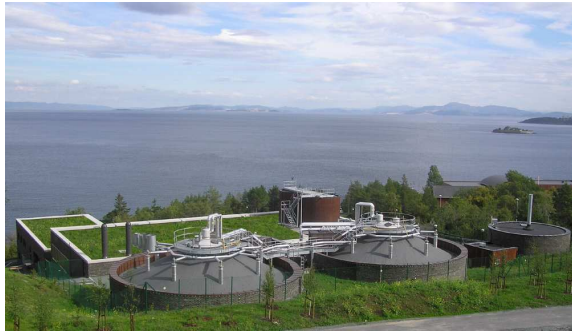
Høvringen rensanlegg. Foto: Trondheim kommune.
