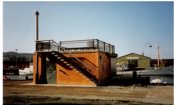
Frostakaia pumpestasjon. Foto: Trondheim kommune.
