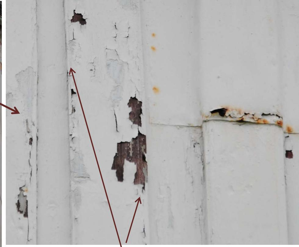
Kantane er forma med øks og etter stokken. Dei er ikkje heilt beine. Deretter er kanten høvla og med karnissprofil. Kvitmålinga flaknar. Det er raudt og feitt under. Første målinga var venteleg med lyse som bindemiddel.
