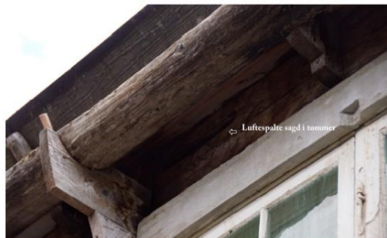
14 Bortover raftstokken er det lagd avlange spalter for å skape lufting mellom torvtaket og isolasjonssjiktet.
