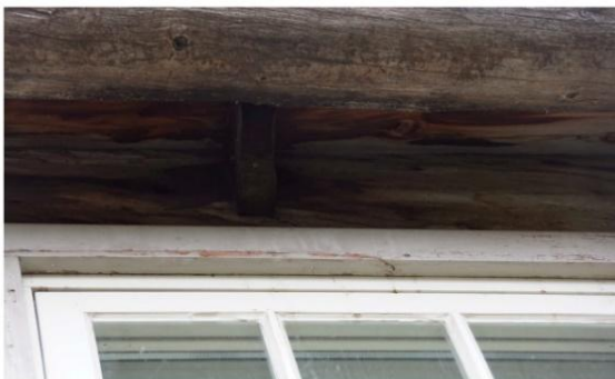
13 Vanmerker fra tidligere lekkasjer på tro, knekt ,tømmer ,omramming og vindu.
