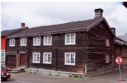
01 Fronten til Per Mundssagården ut mot bergmannsgata.
