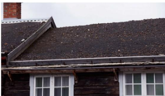
03 Tak over portloftet. På naboeiendommen er det en lignende løsning med bolgeeternitt og slegg som har sklidd nedover takflaten.
