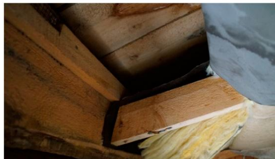
16 Nedsenka himling. Asfaltpapp ligger over isolasjonen. Under isolasjonen er det den pappen som hadde et tynt sjikt med plast som er brukt.
