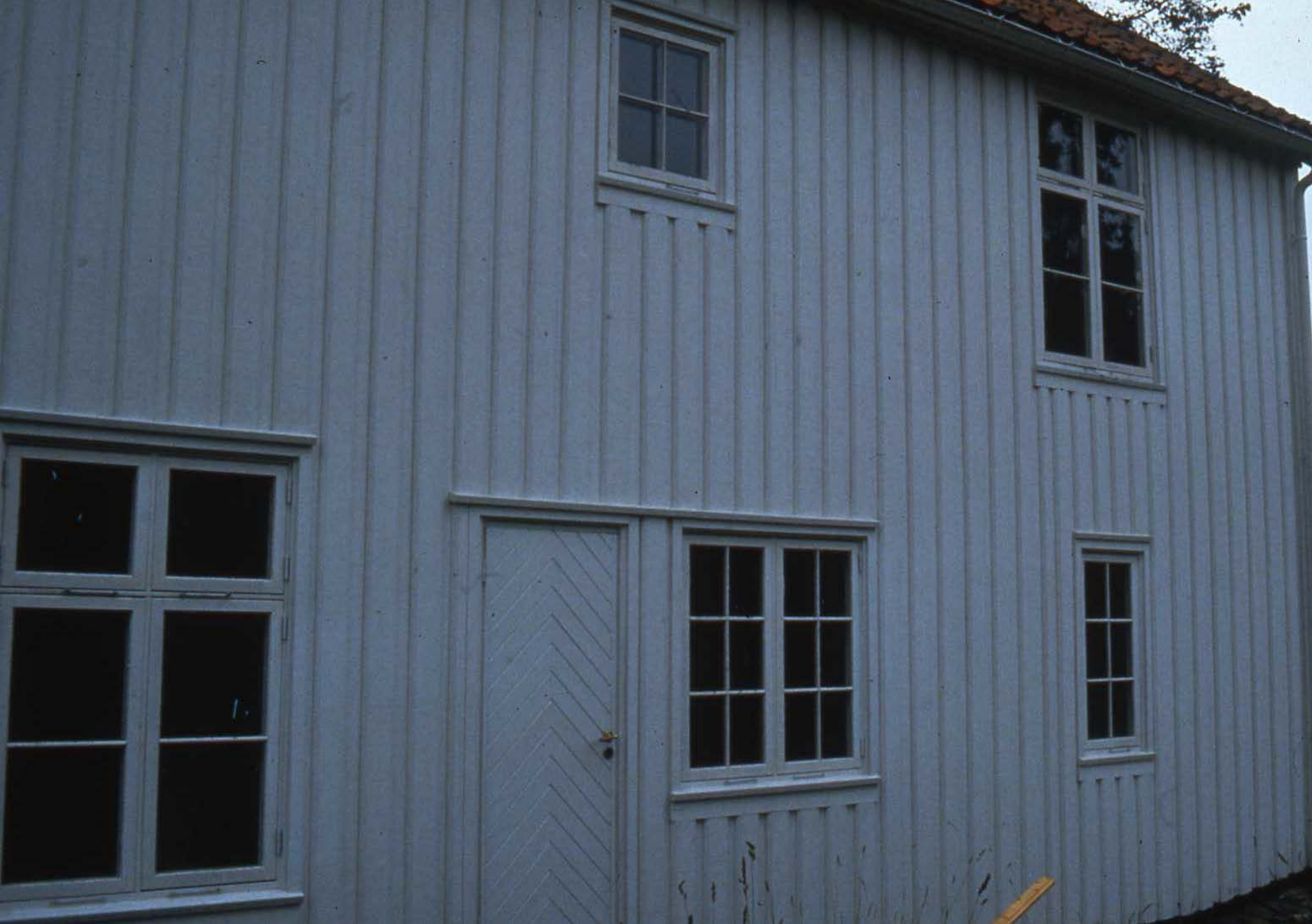
Den restaurerte baksida. Det blir eit heilt anna hus.
