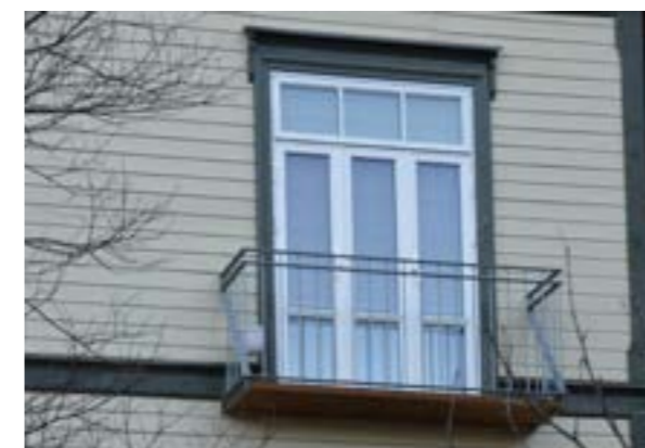
Ny grunn balkong mot gårdsrom/hage. 2003.
