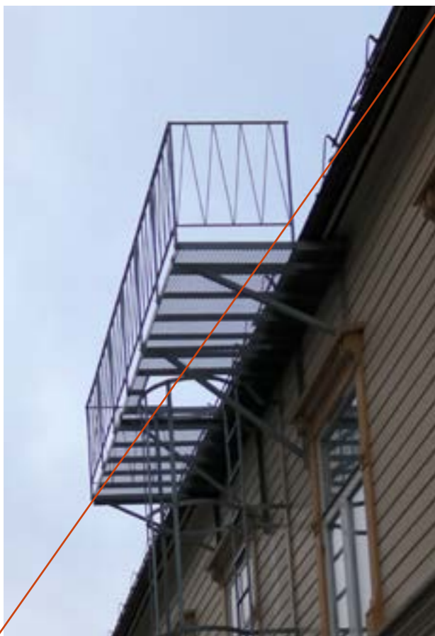
Alle foto på denne siden viser uønskede løsninger på rømning fra loftsplan.
