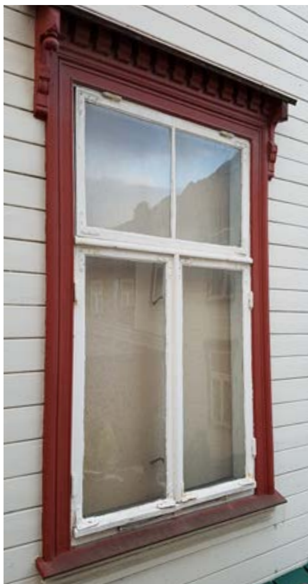
Opprinnelig vindu med 40mm rammer+ kitt. Midtpost er festet i venstre ramme og måler 28 cm. Losholt og bunnkarm stikker frem og er avrundet.
