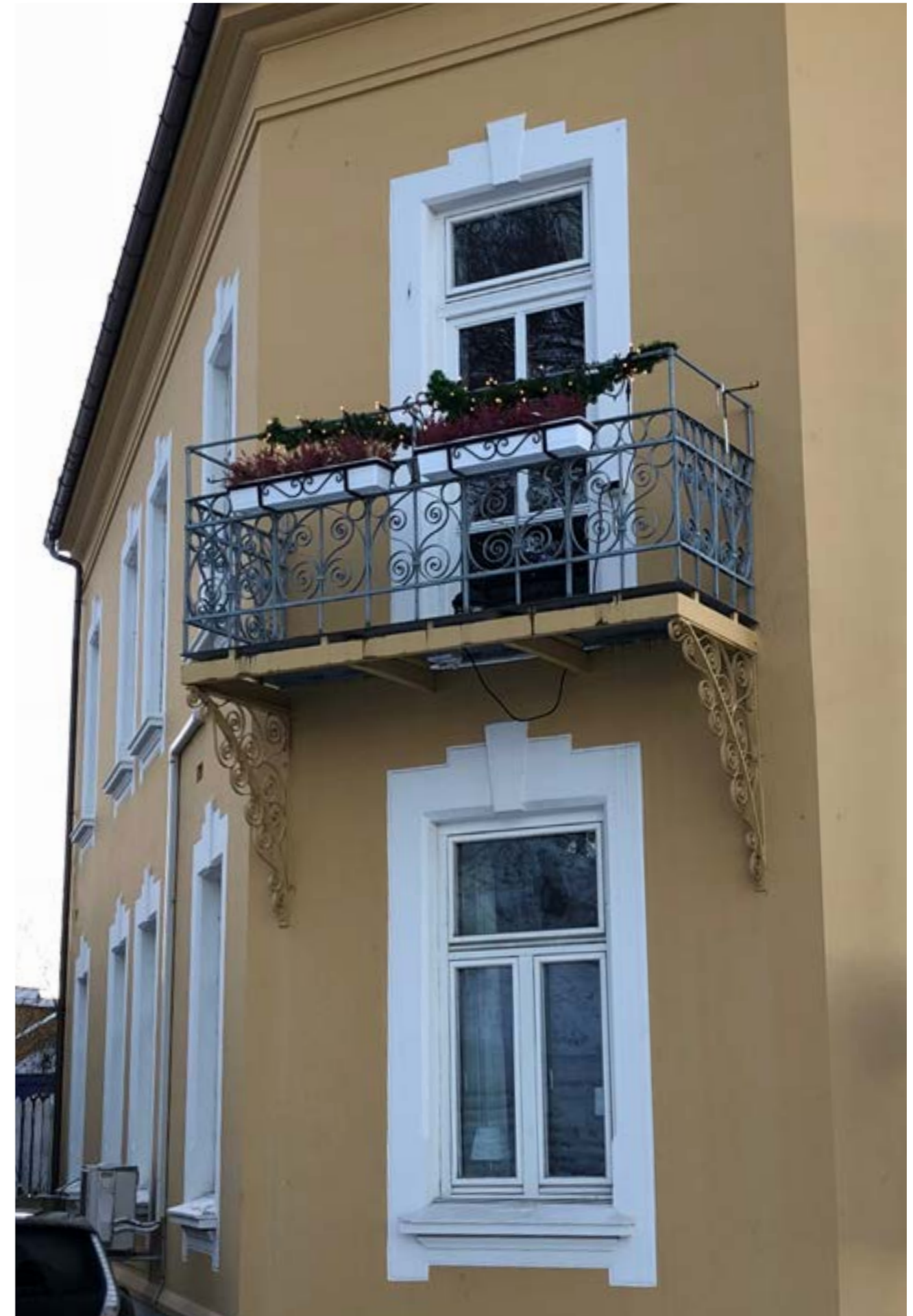
Balkong på murbebyggelse.
