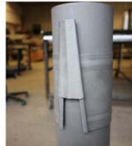
Klammer monteres på avstandstykkene og holder nedløpet fast på vegg. Foto: Terje Granås. Illustrasjon fra byggogbevar.no
