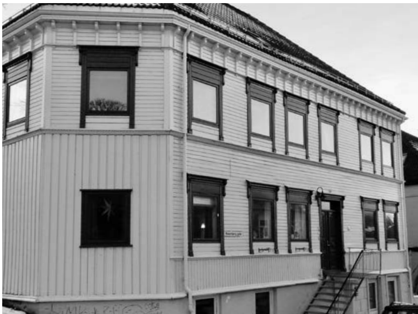
Bygning med potensial for tilbakeføring. 2018.
