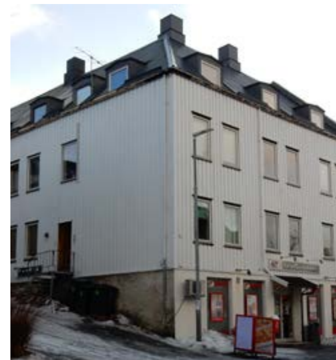
Bygning med potensial for tilbakeføring. Samme bygning som vist under.
