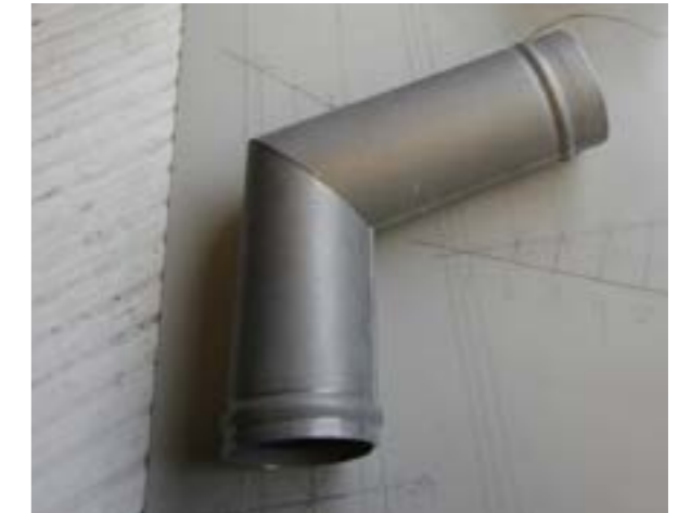
Knekte bend. Vulst på utspyler. Foto: Terje Granås. Illustrasjon fra byggogbevar.no
