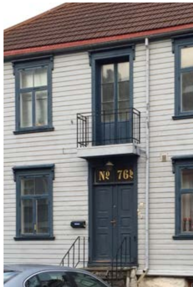
Ny balkong og balkongdør etablert etter 1975.
