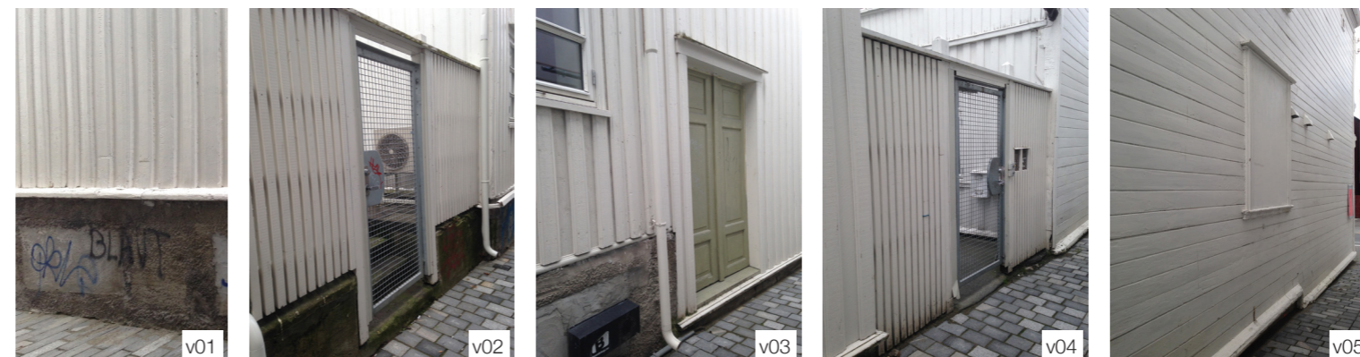
85. Kuskveita vest fasade - detaljer, materialbruk og fargepallett. Bygninger v01-v05 (under: sekvens fra venstre til høyre)
