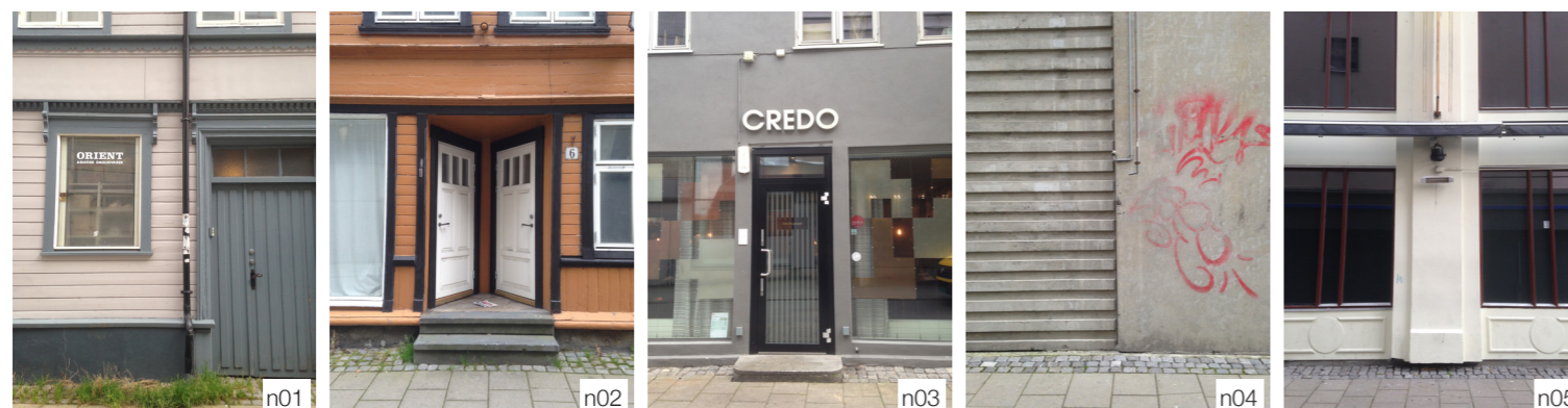
103. Taraldsgårdsveita nord fasade - detaljer, materialbruk og fargepallett. Bygninger n01-n05 (under: sekvens fra venstre til høyre)
