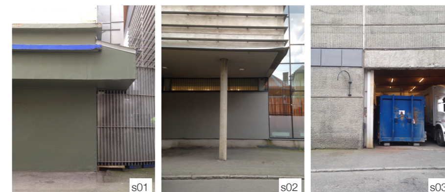
104. Taraldsgårdsveita sør fasade - detaljer, materialbruk og fargepallett. Bygninger s01-s03 (under: sekvens fra venstre til høyre)
