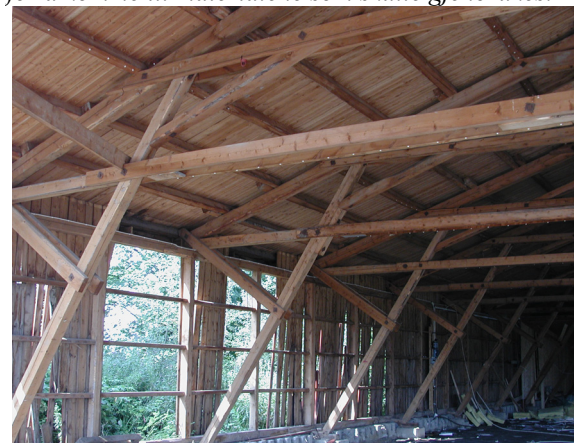
Det var mye trevirke i konstruksjonene som var boltet sammen med jernbolter.
