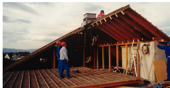
Entreprenør Håkon Lunde i gang med miljøvennlig riving av tak ved St. Olavs Hospital.
