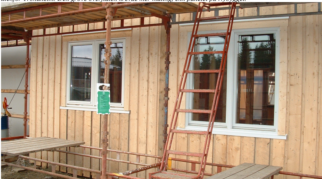
De brukte vinduene (til høyre) fra Søsterboligene ved St. Olav Hospital fremstod som nye etter restaureringen.
