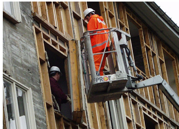
Først ble vinduene løsnet fra veggen og sikret.
