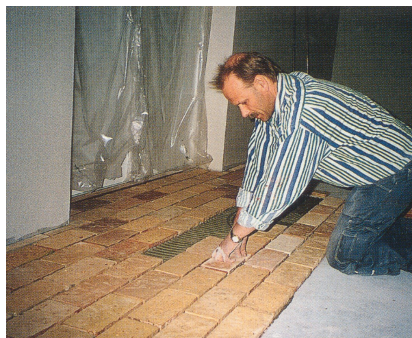
Legging av flisegolv av saget teglstein hos SYSAV.
