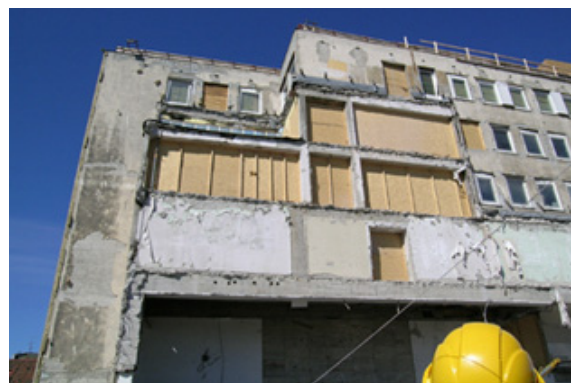
Riving ved ombygging av sentralbadet i Trondheim.
