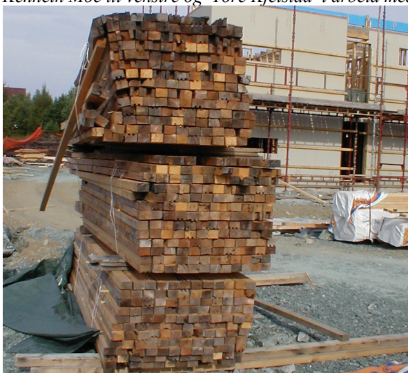
Gjenbruksmaterialer til utlekting stablet på byggeplassen. Disse materialene er laget av gammel laftaplank som ble omdimensjonert på Stavne Gård sin bruksentral ReBygg.
