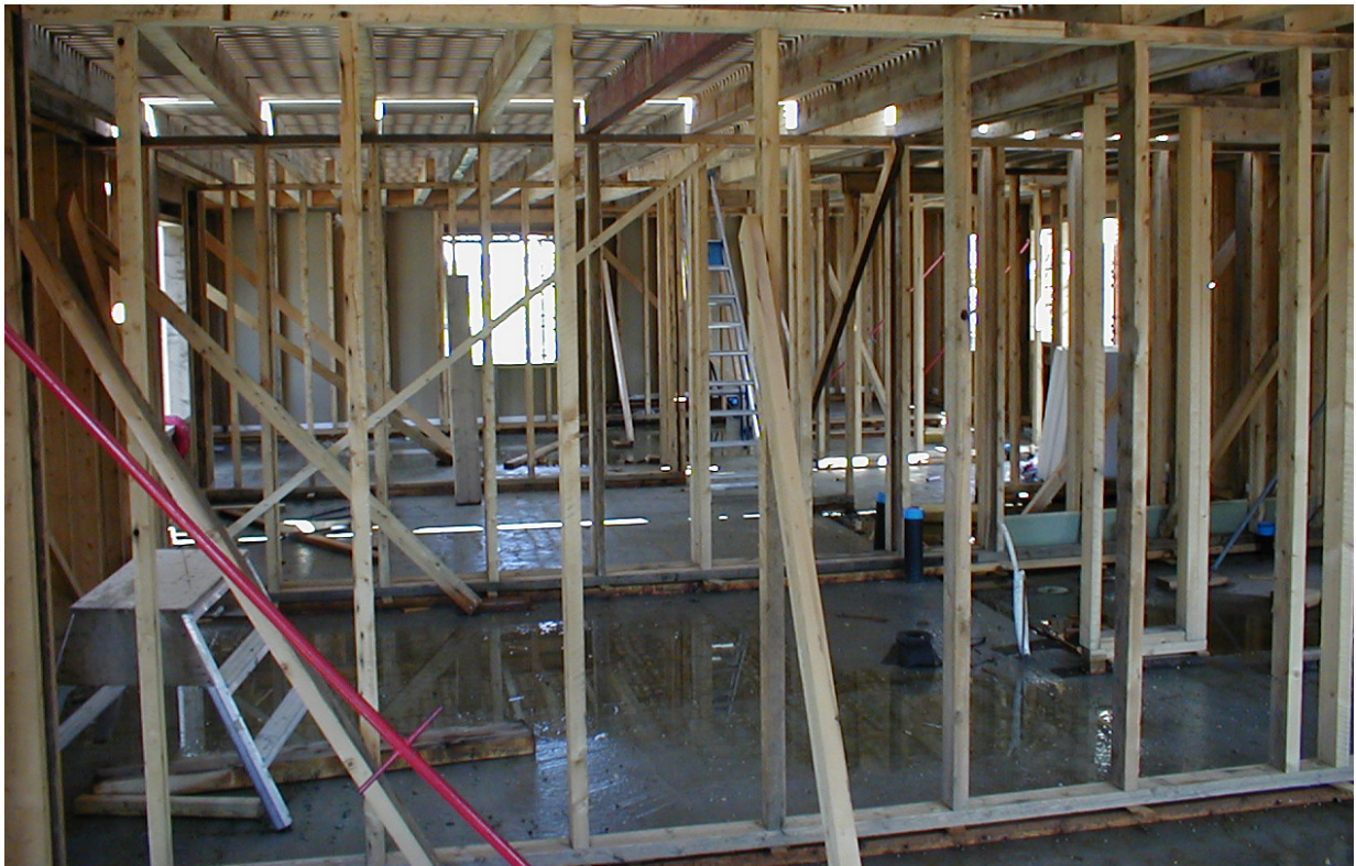
Råbygg med stenderverk av gammelt trevirke.
