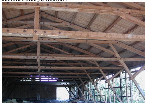
All ytterkledning ble fjernet før trebjelkene ble løftet ned maskinelt og rensket av ReBygg sitt arbeidslag.
