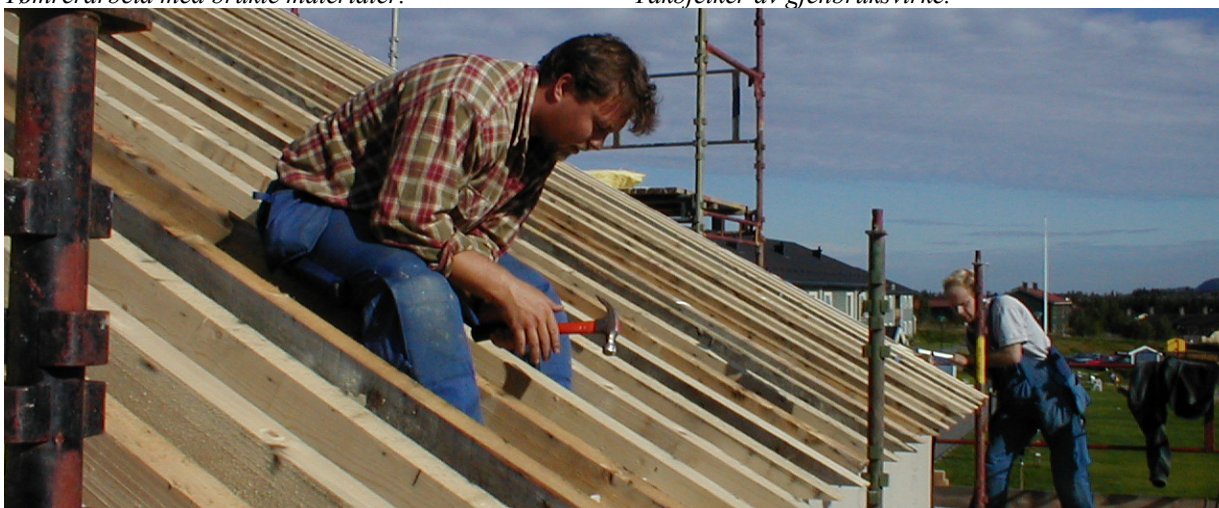
Mangel på gjenbruksmaterialer i rett dimensjon førte til bruk av mindre dimensjoner og kortere senteravstand enn planlagt på taket. Materialmangelen skyldtes blant annet misforståelser om merking og materialbruk. Kenneth Moe til venstre og Tore Kjelstad i arbeid med takkonstruksjonen.
