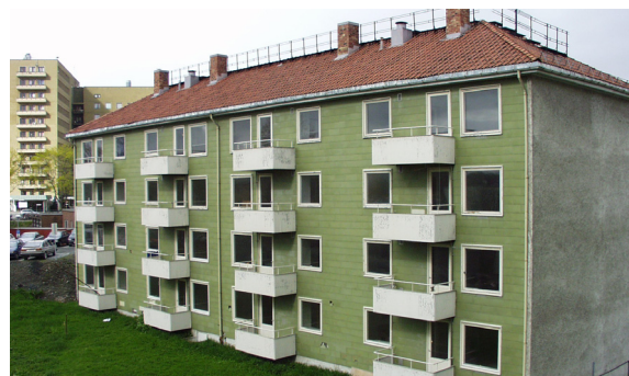
Blokkene i Mauritz Hanssens gt ble strippet fullstendig før de ble revet av AS Anlegg. Kommunens gjenbruksprosjekt i regi av Stavne demonterte innvendig for gjenbruk. Taksteinen ble brukt på Gjenbrukshuset.
