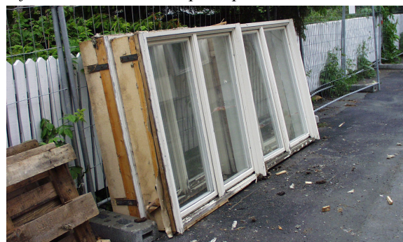
Vinduene ble mellomlagret på riveområdet før de ble fraktet til lagring på ReBygg.
