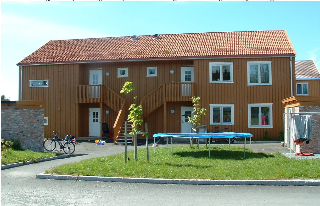
Gjenbrukshuset har blitt et stedtilpasset og funksjonelt bolighus hvor beboerne trives godt.
