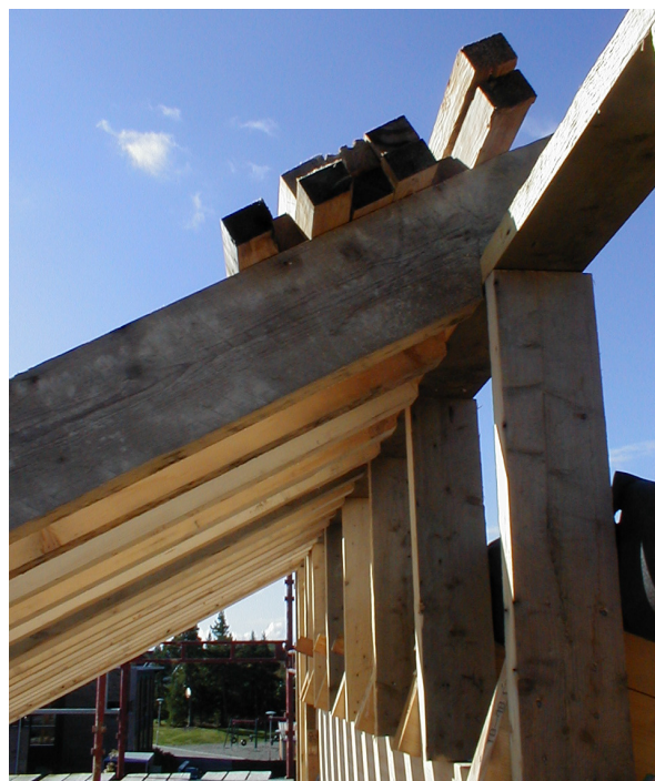
Takbjelker av gjenbruksvirke.
