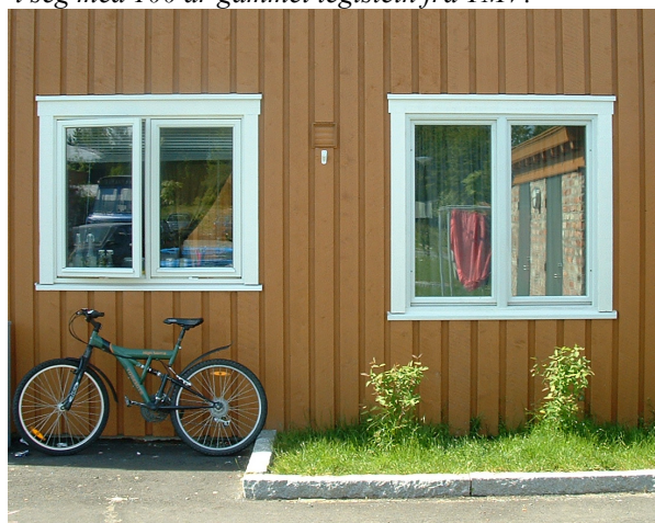
Nytt og gammelt side om side. Ikke lett å se at vinduet til høyre har hatt et tidligere liv.
