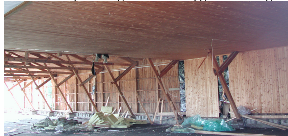
Noen av brakkene hadde kledning som måtte fjernes for å komme til materialene som skulle gjenbrukes.
