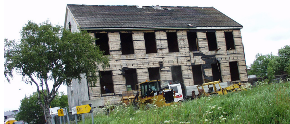
Huset ble strippet både ut- og innvendig før tømmerkassen ble demontert.
