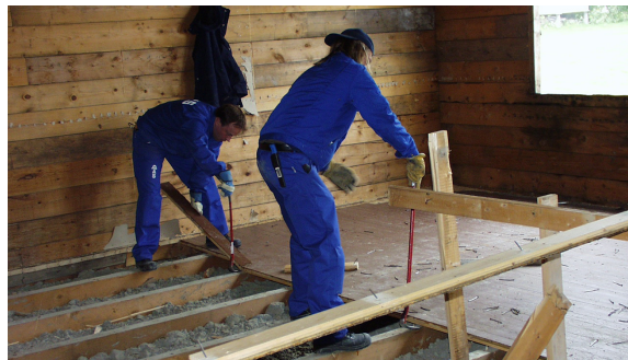
Stavnens arbeidslag demonterer golvbord for gjenbruk. Arbeidsleder Albert Steen til venstre.
