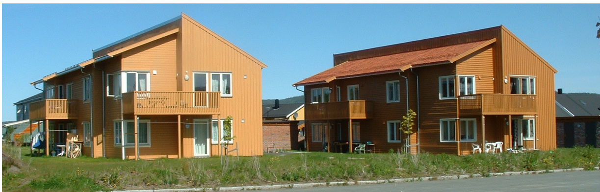
To "like" hus på Hølbekken - ikke så lett å se at huset til høyre er bygget med en stor andel gjenbruksmaterialer.
