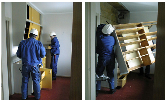
Kjøkkeninnredningene ble demontert forsiktig.
