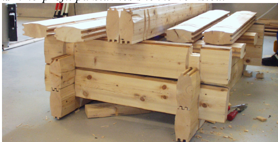
Lafting med omhøvlet gjenbruksvirke.
