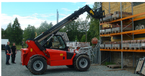
Palleløfting med teleskoplift.
