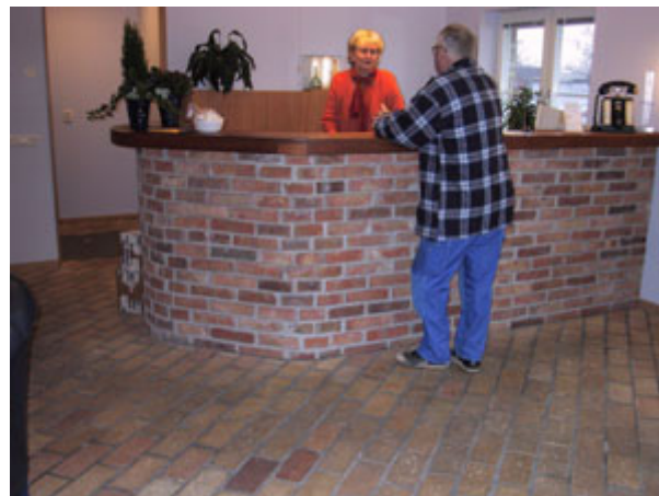
Gjenbruk av saget tegl som golvflis og ombrukstegl som resepsjonsdisk. Bilde fra SYSAV sitt hovedkontor i Malmø. Teglfliene er fra produktutvalget hos Malmø Återbyggdepå som også produserer disse med spesialsag. Bilde av sagen er vist på side 70.
