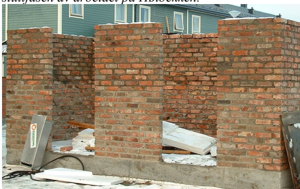
Muring med gjenbrukstegl.
