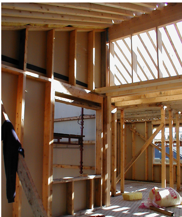
Tømmerarbeid med brukte materialer.
