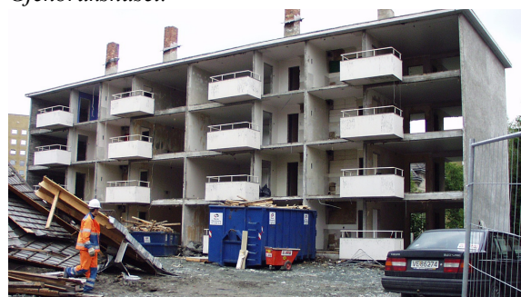
Blokkene i Mauritz Hanssens gt ble strippet fullstendig før de ble revet av AS Anlegg. Kommunens gjenbruksprosjekt i regi av Stavne demonterte innvendig for gjenbruk. Taksteinen ble brukt på Gjenbrukshuset.
