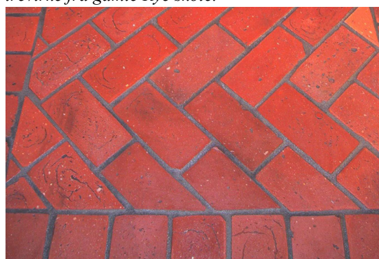
Golv med fliser av saget gjenbrukstegl på Stavne Gård. Stavne ønsker å kjøpe eller utvikle utstyr for å produsere slike fliser selv ved ReBygg. Dette kan bli en ny arbeidstreningsaktivitet og et salgbart produkt.
