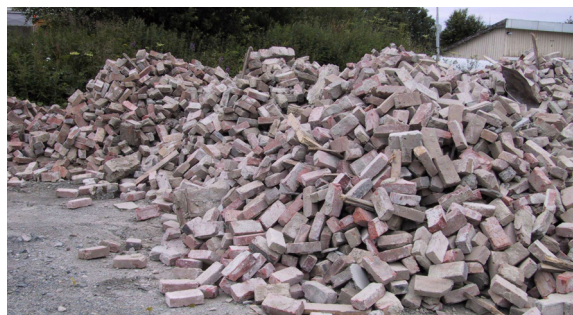
Entreprenøren fraktet en blanding av hele og knuste stein til ReBygg for videre bearbeiding og bruk.
