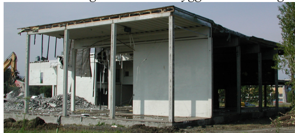
Også enkelte bygningsdeler fra betongbyggene ble revet for gjenbruk.
