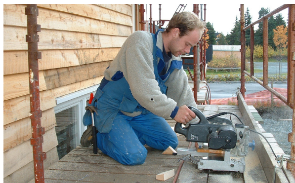
Tore Kjelstad i arbeid med å legge ytterkledning av omdimensjonert gammel laftaplank.
