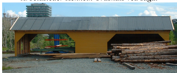
Nytt saghus våren 2004, bygget med gjenbruksmaterialer og egenproduserte trematerialer.
