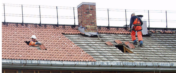
Ved å lage åpninger i taktroen kunne steinene tas inn på loftet og stables på paller for nedheising.
