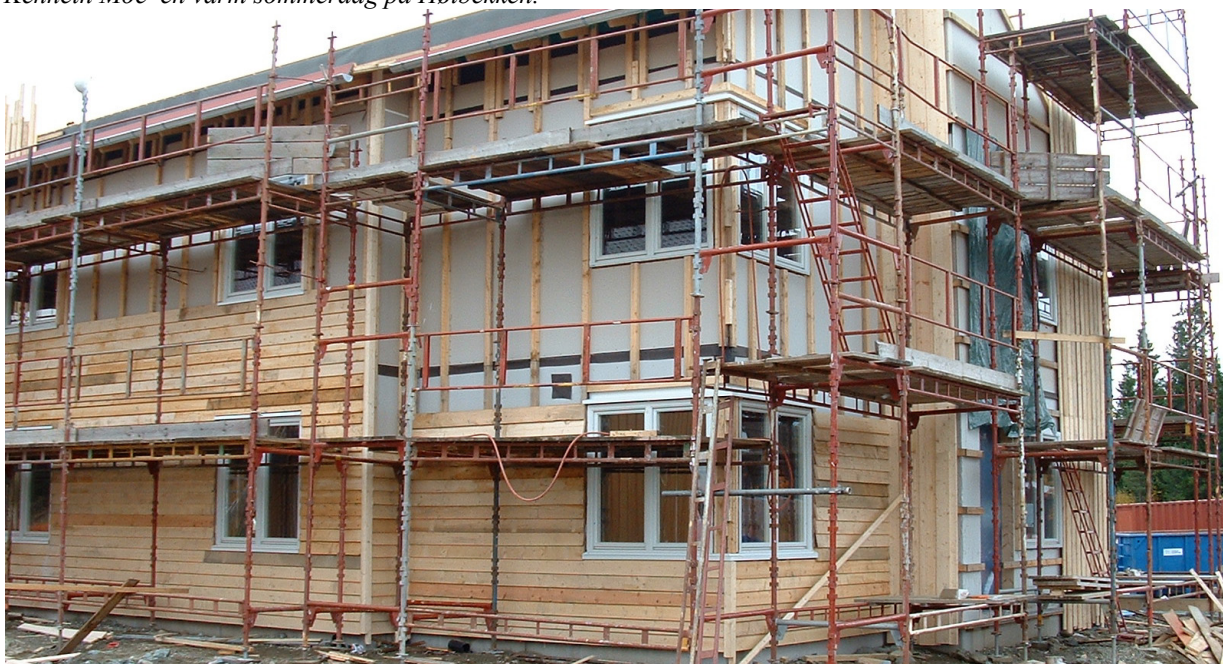
Gjenbrukshuset ble kledd med stående og liggende panel som var laget av plank fra gamle Rye skole på Byneset utenfor Trondheim. Den grove overflaten krevde mer maling, enn panelet på Nybygget.
