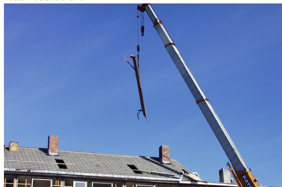
Løse enkeltbjelker ble også tatt ned med kran.
