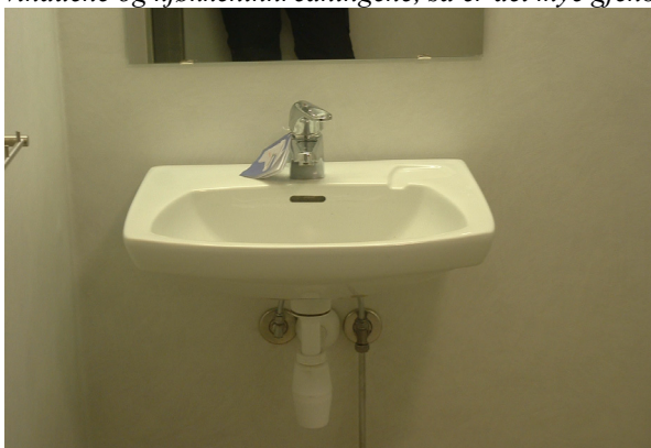
De gamle vaskene fikk nye blandebatterier før montering.
