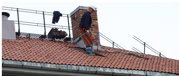
De første taksteinene ble lagt unna på takstigene.
