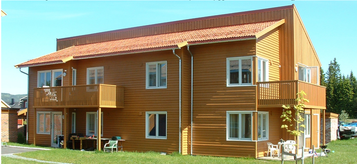
Eksteriør med gjenbrukspanel av gammel plank, samt 40 år gamle takstein og vinduer fra rivningen ved St. Olav.
