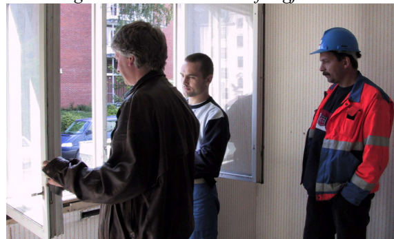
Arkitekt, vindushåndverker og anleggsleder vurderte vinduskvaliteten i god tid før riving.
