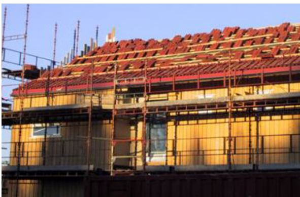
Pga stablemetoden ble det en del ekstraarbeid med å få de brukte taksteinene opp på taket.
