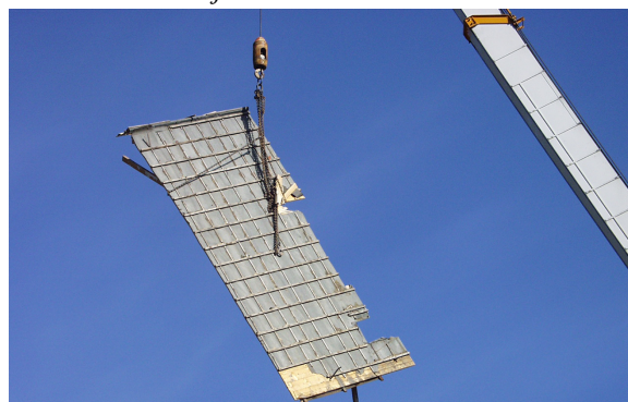
Takseksjonene med bjelker og taktro ble løftet ned med mobilkran.
