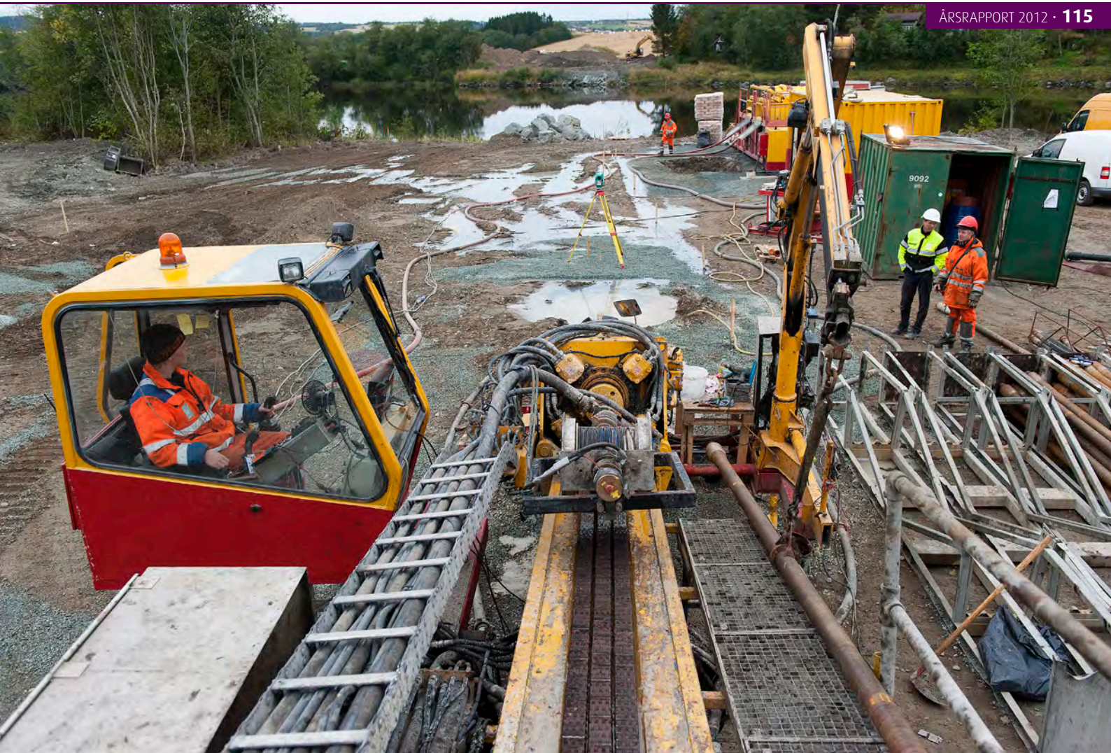
Fra utbyggingen av MeTroVann. Forberedelser til trekking av rørledning under Gaula. (Foto: Carl-Erik Eriksson)
