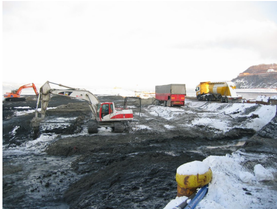
Figur 4-8. Alle forurensede masser som graves opp i Trondheim, skal leveres til godkjent mottak. (Foto: Rambøll)
