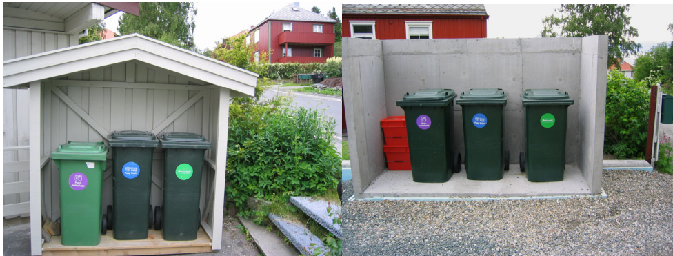
Figur 2-5. Eksempler på innebygging av avfallsbeholdere hos abonnenter i småhusbebyggelse (Foto: Rambøll)
