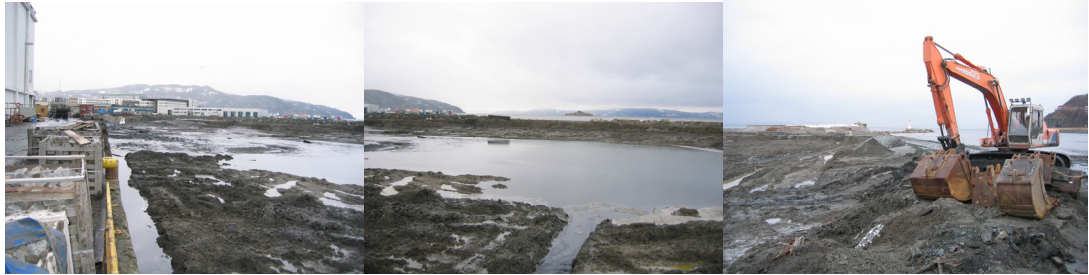
Figur 2-20. Oppfylling av deponi for forurensede sedimenter ved Pir II i 2002. Deponiet er nå avsluttet. (Foto: Rambøll)
