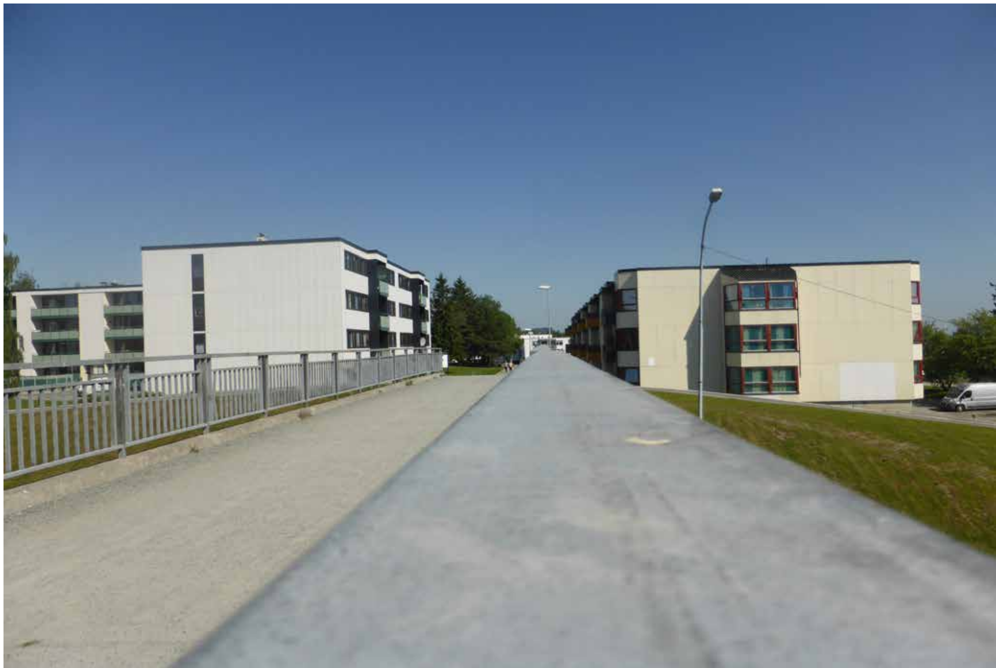
Figur 3: Bilde av broen til Kolstadflaten borettslag sett fra Saupstadsenteret.
