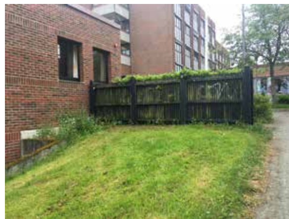
Figur 21: Før-bilde av leveggen ved det øvre torget.
