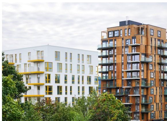
Høyhus på Nye Lilleby vokser frem blant trærne. Foto: Byarkitekten, Trondheim kommune
