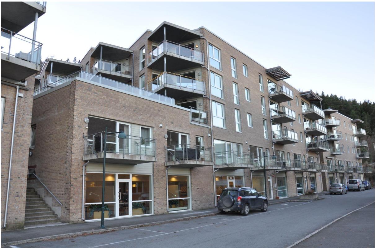
BRA: Mellomila 93 har et helhetlig arkitektonisk konsept, er tilpasset terrenget og har aktive fasader mot gate.
