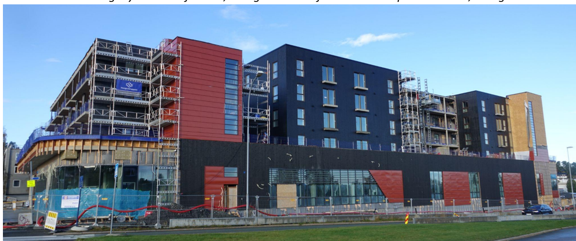
UHELDIG: Byåsveien 162. Lukkede fasader, dårlig tilpasset terrengfall, ingen arkitektonisk helhet.
