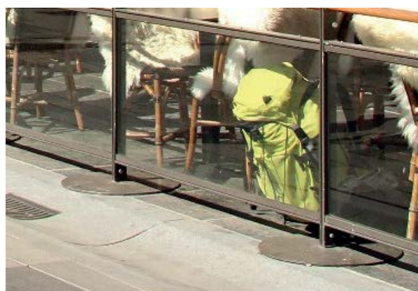
Bildet viser gunstig fot laget av stålplate.
