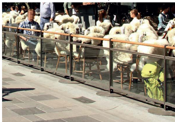
En avgrensning med toppliste av tre, fremstår som en god løsning. Høyden på denne er 90 cm. Denne høyden føles behagelig for en gjennomsnittlig høy person som sitter.
