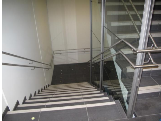
Detalj Ranheim skole, markering av trappeneser.
