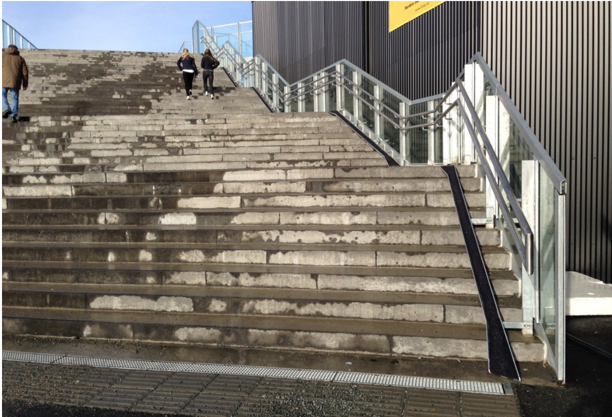
Sykkelskinne langs trappeløp gir mulighet for transport av sykkel over Sjøgangen
