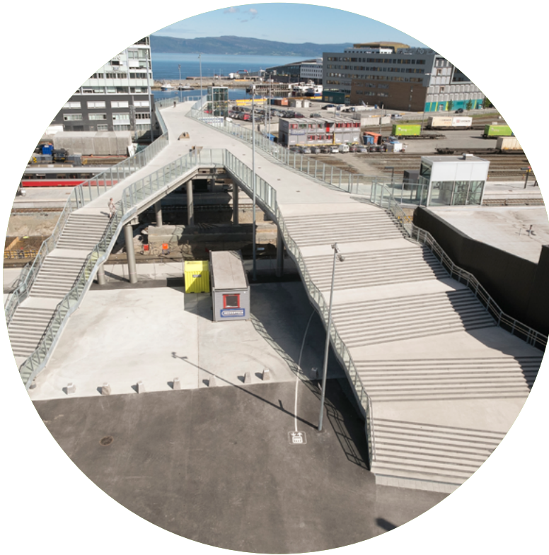
Fotoet viser Sjøgangen, en gang- og sykkelbro ferdigstilt i 2013, blant annet med midler fra Miljøpakken. Foto Carl-Erik Eriksson/Trondheim kommune
