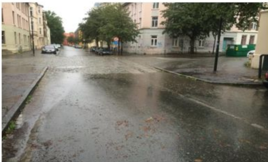
Figur 19: Bildet viser dårlig drenering som medfører at vann trenger inn i vegens overbygning, Ulstadløkkvegen.
