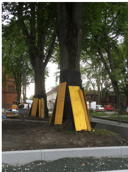
Planker utenpå mattene gir noe bedre beskyttelse, men skulle ideelt sett vært bygget som en kasse med støtdempende materiale inni.
