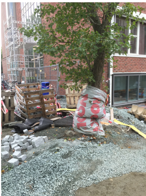
Beskyttelse som først og fremst fungerer som blikkfang for å unngå sammenstøt, gir ikke reell beskyttelse mot mekaniske skader.
