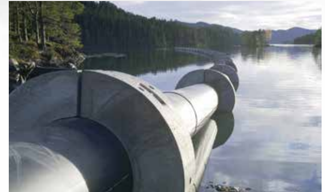
Inntaksledning i Benna.
