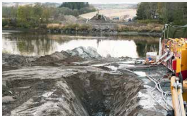
Kryssing av Gaula.
