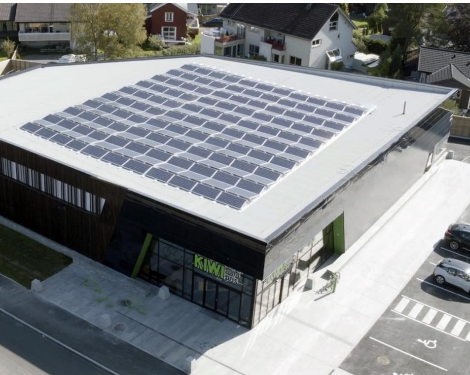
Tynnfilm solceller på tak og krystallinske solceller på fasader, (byggningsintegrert solcellesystem - BIPV). I alt 579 m 2 solceller med batteribank for lagring av solenergi.
