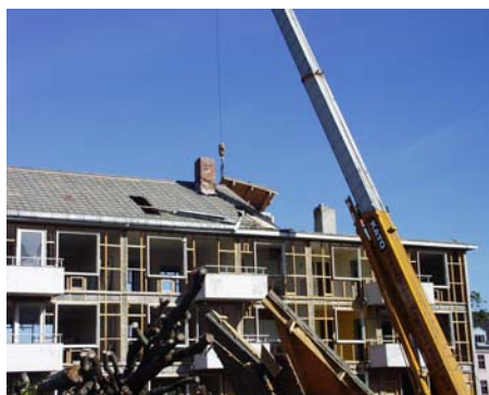
Takbjelker rives ved at takflaten tas ned seksjonsvis med mobilkran, taktro fjernes fra takbjelkene med maskin med hydraulisk grep
