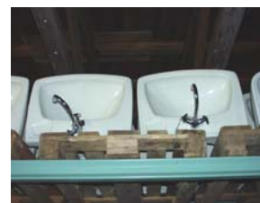
Fra demontering av vasker og armatur, til mellomlagring og reollager OAS.
