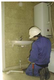
Fra demontering av vasker og armatur, til mellomlagring og reollager OAS.
