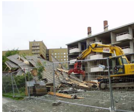
Takbjelker rives ved at takflaten tas ned seksjonsvis med mobilkran, taktro fjernes fra takbjelkene med maskin med hydraulisk grep
