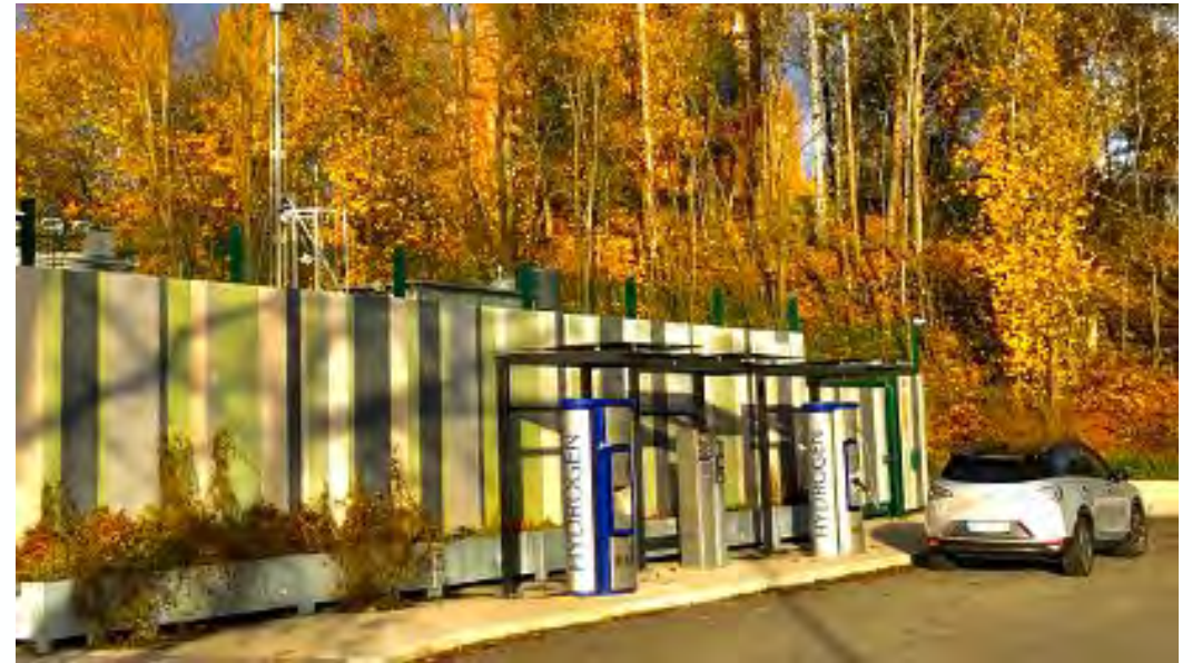
Hydrogenstasjonen på Høvik, Bærum. Foto: Hynion
