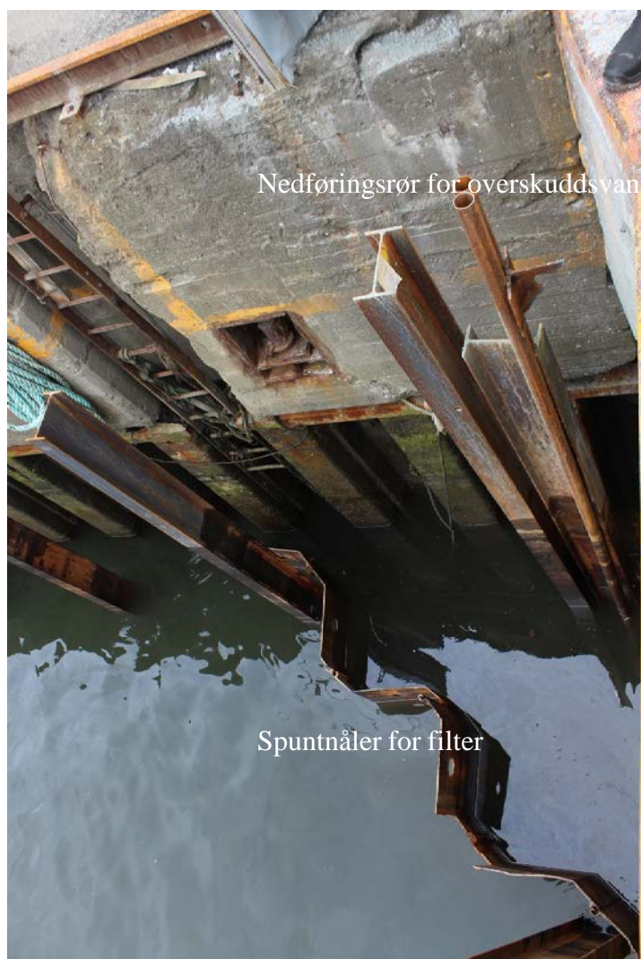
Figur 2 Spuntvegg og nedføringsrør for filtrering av overskuddsvann.
