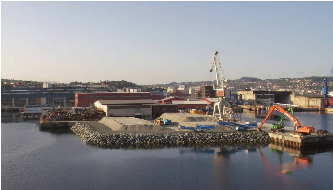
Figur 3 Ferdig strandkantdeponi som benyttes som mellomlager for tildekkingsmasser (Foto: Renere havn).
