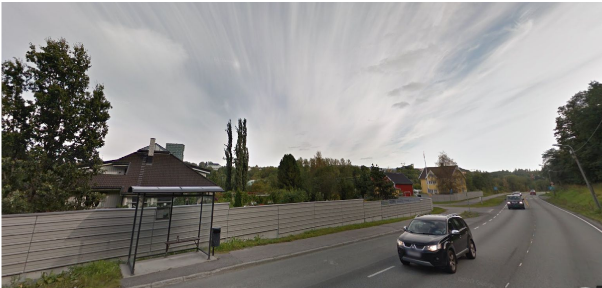
Rv. 706 Osloveien v/Sivert Dahls veg. Foto: Google Maps
