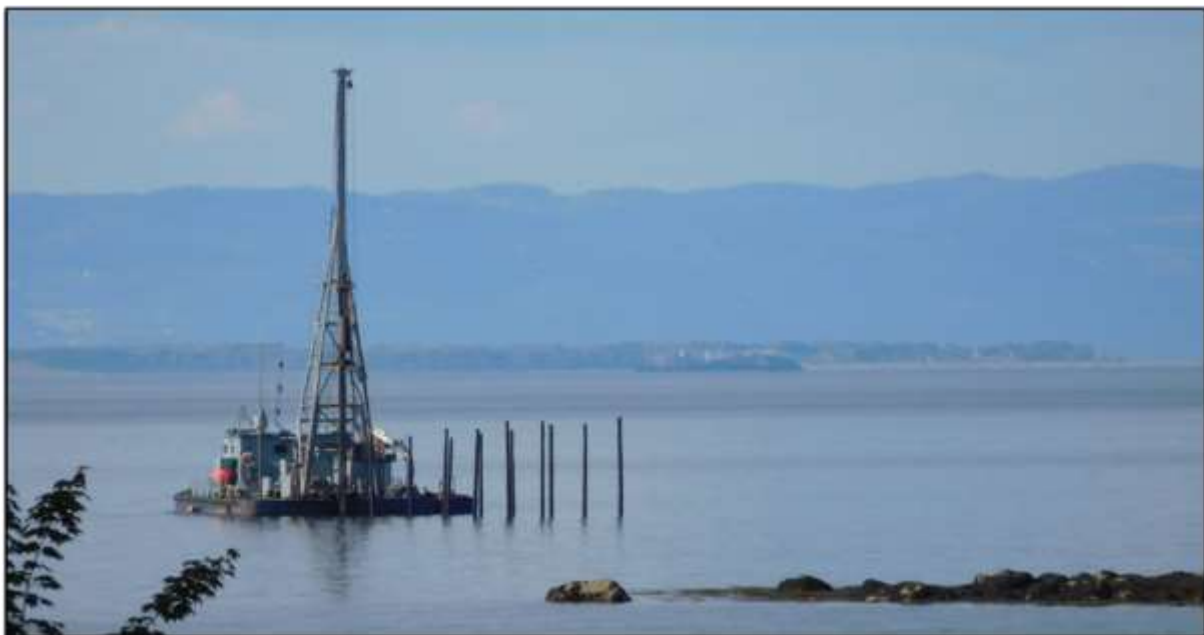
Bilde 18. Oppføring av pålene, 16. juni 2016.
