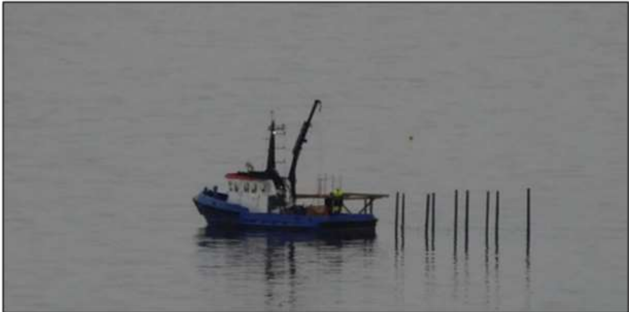
Bilde 19. Oppstart bygging av plattform, 31. august 2016.
