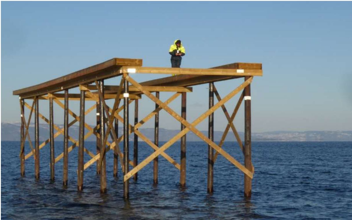
Bilde 22. Befaring av ferdigstilt plattform, 8. november 2016. Plattformen beveget seg overraskende mye, selv om det knapt var bølger til stede.
